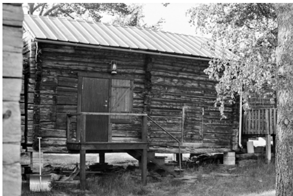
Figur 24. Bod 3–4, fotograferade 1967. Fönstret till vänster om dörren har satts igen. Foto: Per-Uno Ågren/VBM (K 1326 31).
