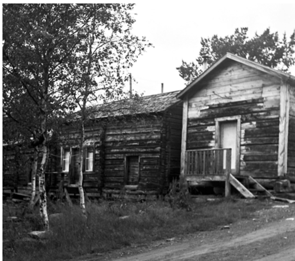
Figur 26. Bod 3–4 och 5, fotograferade 1948. Två fönsteröppningar har tagits upp i bod 3, men den vänstra är numera igensatt. Foto: troligen Gunnar Westin/VBM (A 875).
