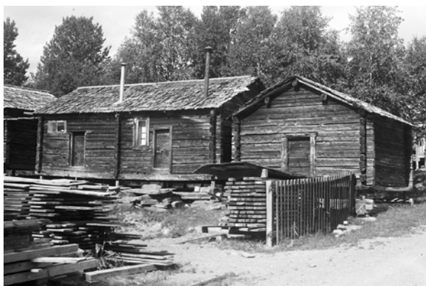
Figur 30. Bod 8–9 och 10, fotograferade under något av 1900-talets första decennier. Bod 10 står nu snett bakom bod 8–9, vänd åt andra hållet. Foto: Hilmer Zetterberg/VBM (B 6734).
